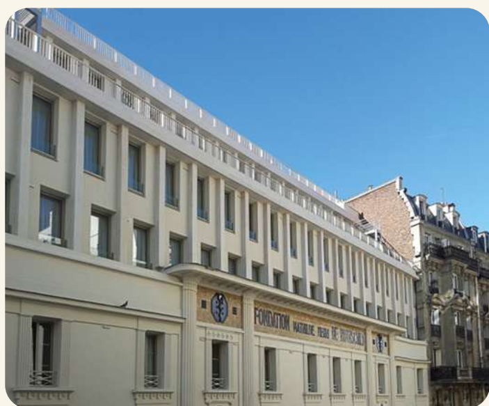
Figure 7 : Résidence Jean-Baptiste Carpeaux. Façade principale, 2023, photographie numérique.
